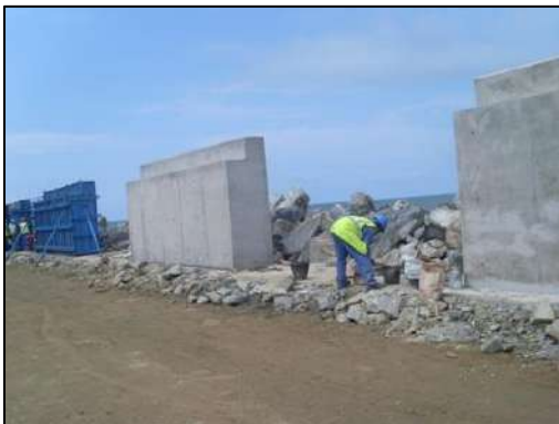
Bétonnage des murs périphériques de digue en enrochements
