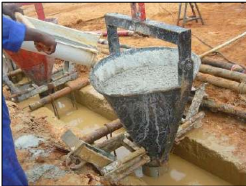
Bétonnage des parois moulées du quai
