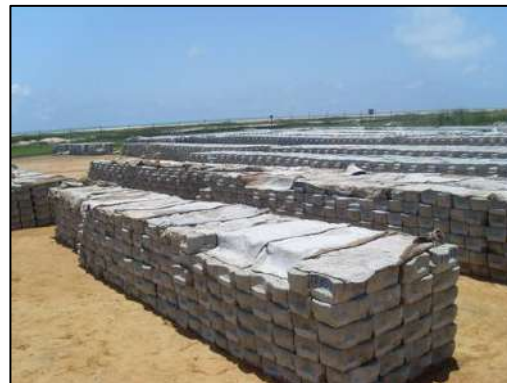
Stockage des pavés préfabriqués
