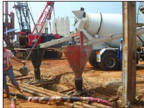
Bétonnage des parois moulées du quai
