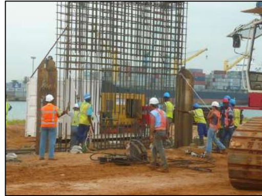
Ferraillage des panneaux de quai à parois moulées
