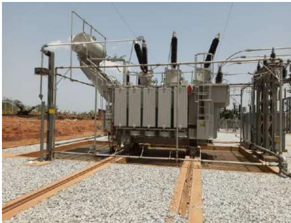
Construction de sous-station transformation HTB/HTA
