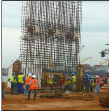
Ferraillage des panneaux de quai à parois moulées
